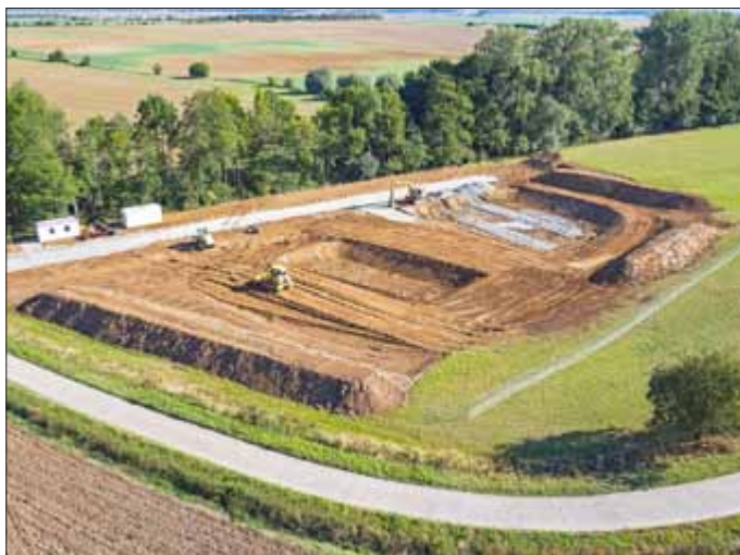
Mit dem Neubau der Kläranlage Schildbach entsteht eine zentrale, vollbiologische Kläranlage für 2.400 Einwohnerwerte.
